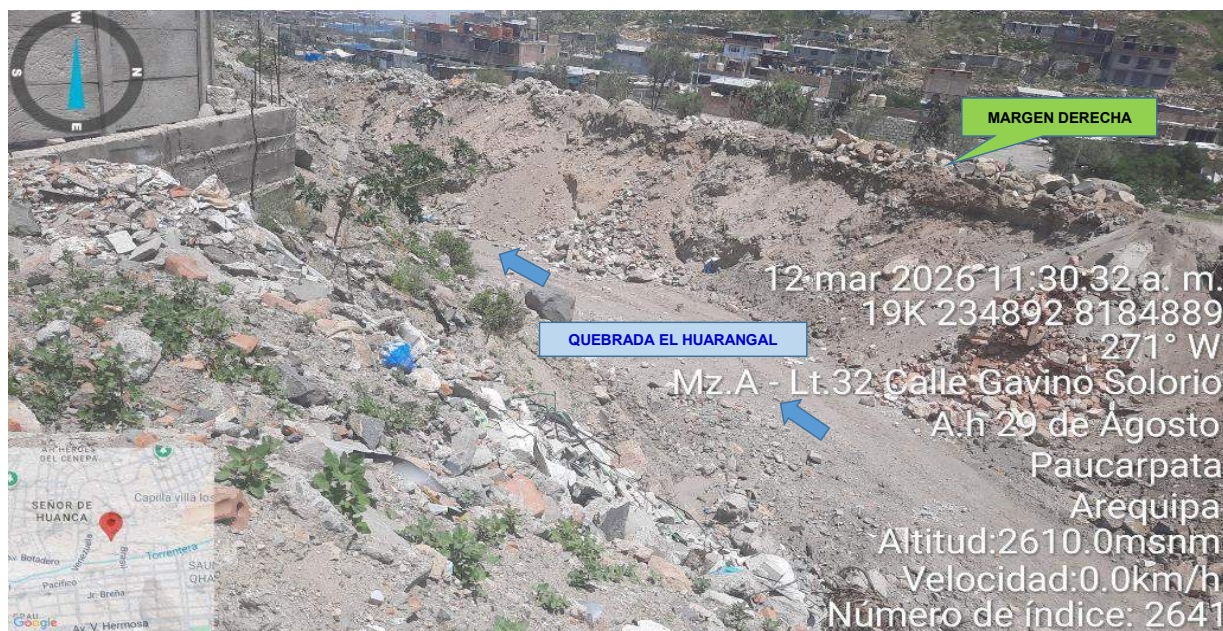
IMAGEN 02: EN ESTE TRAMO SE OBSERVA EN LA MARGEN DERECHA DE LA QUEBRADA EL HUARANGAL, SU TALUD SE ENCUENTRA SOCAVADO DESLIZABLE Y SIN PROTECCIÓN, Y VIVIENDAS CERCANAS A DICHA MARGEN.
