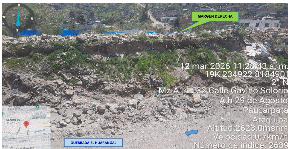
IMAGEN 03: EN ESTE TRAMO SE OBSERVA EN LA MARGEN DERECHA DE LA QUEBRADA EL HUARANGAL, SU TALUD SE ENCUENTRA SOCAVADO DESLIZABLE Y SIN PROTECCIÓN, Y VIVIENDAS CERCANAS A DICHA MARGEN
